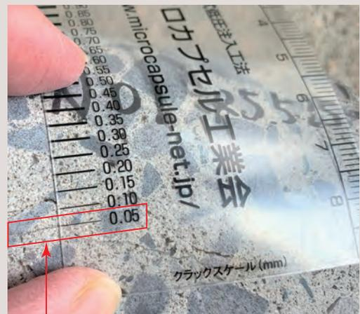
低圧により 0.05 mm にも充填されている
